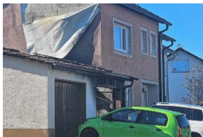
Eine Garage an der Lerchenstraße in Donaueschingen ist nach einem Brand völlig zerstört. FOTO: DENISE KLEY
