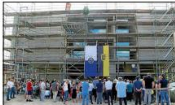
Zahlreiche Gäste kamen zum Richtfest und hatten auch Gelegenheit, einen Blick ins Innere des Rohbaus zu werfen.
