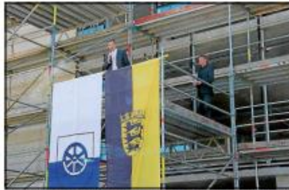
Eine besondere Tribüne hoch oben auf dem Baugerüst hatte Oberbürgermeister Erik Pauly während seiner Ansprache.
